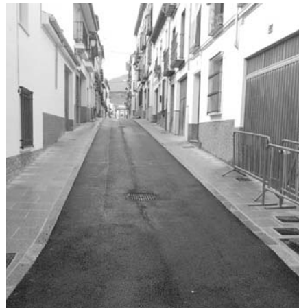
Finalización de las obras en calle Plato. VIVA
