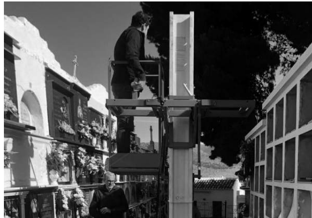
Plataforma elevadora. VIVA
