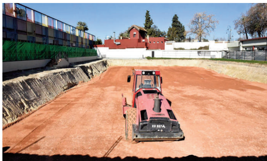
Obras antes del estado de alarma VIVA
