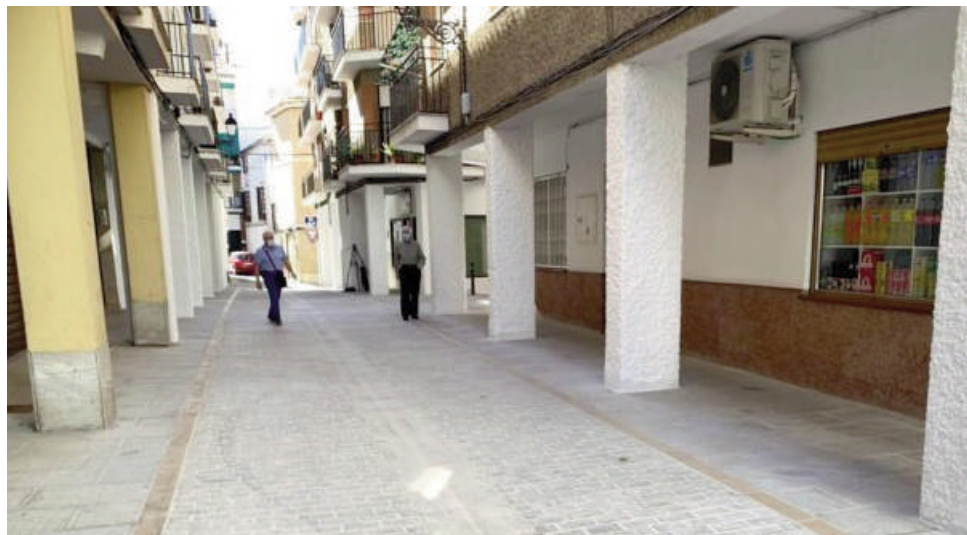
Finalización de la obra. VIVA
