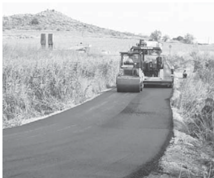
Imagen de las obras. VIVA
