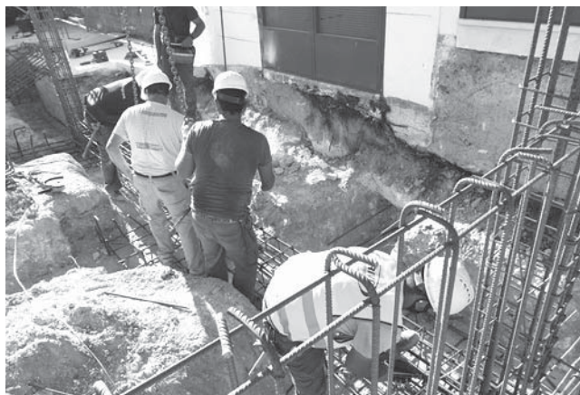
Imagen de las obras. VIVA
