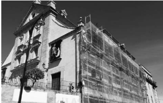
Vista de la fachada lateral en obras. VIVA
