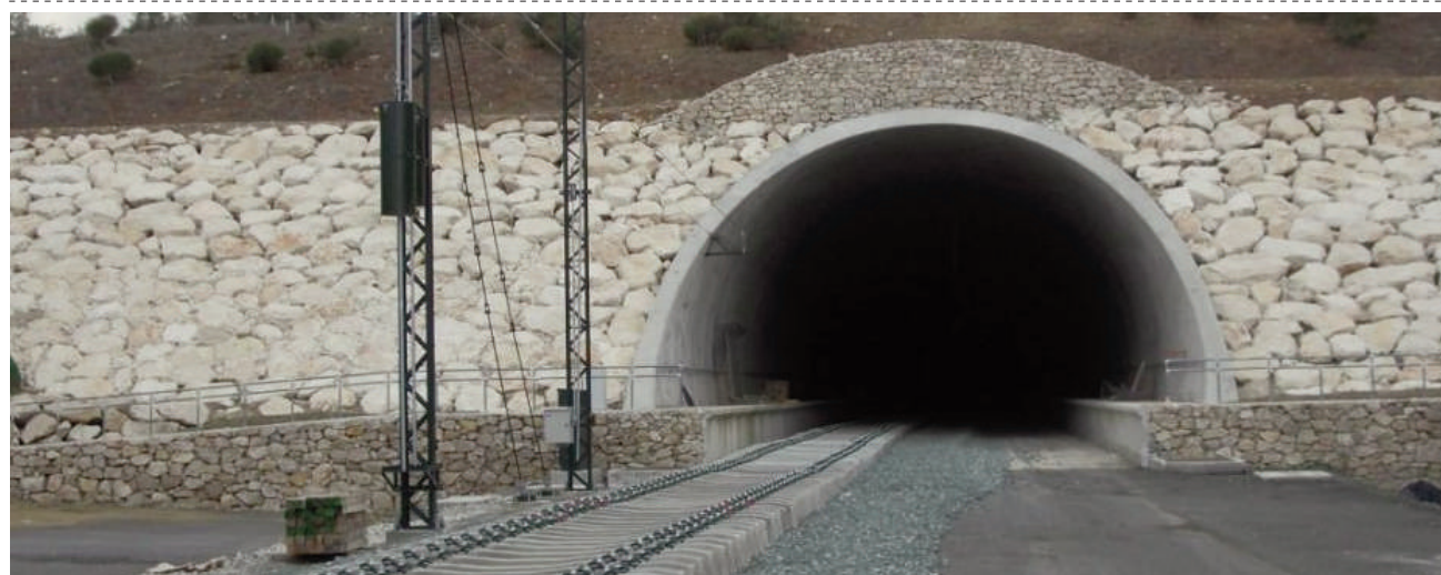
Fotografía del túnel. VIVA
