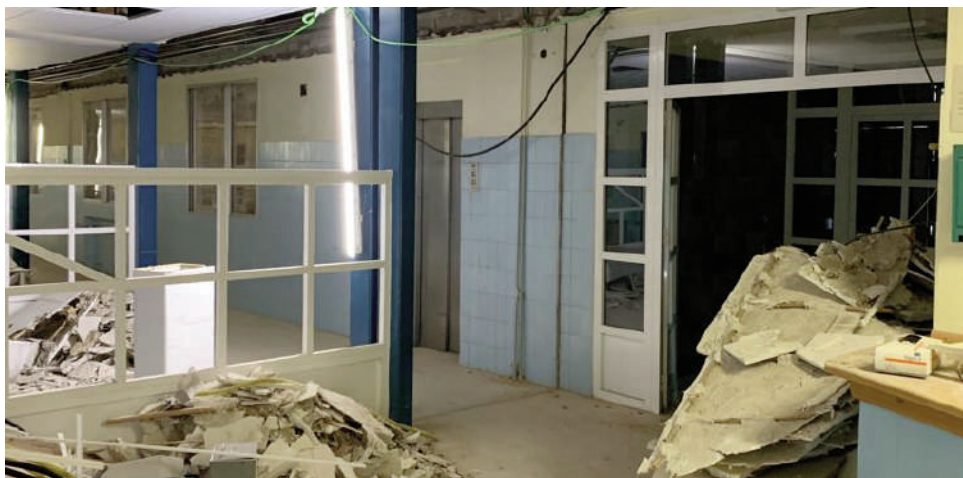
Obras en el interior del centro de salud. VIVA
