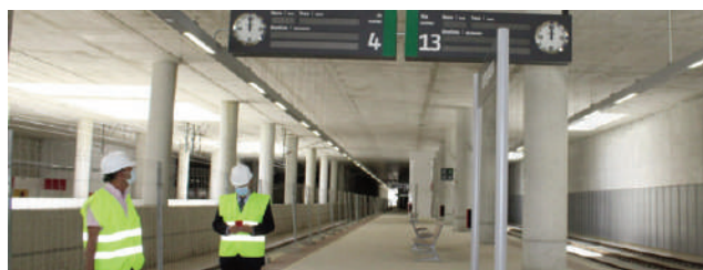
Estación en obras. VIVA
