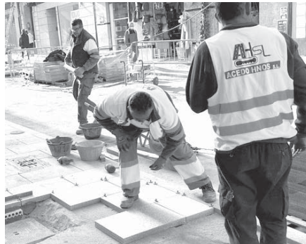
Obreros trabajando en calle Estepa. VIVA
