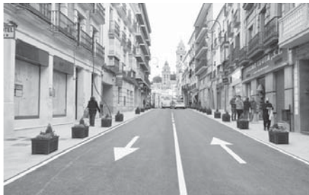
Tramo recién finalizado. VIVA
