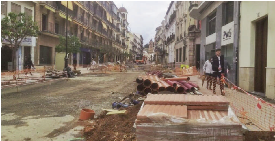
Obras calle Infante Don Fernando de Antequera. VIVA
