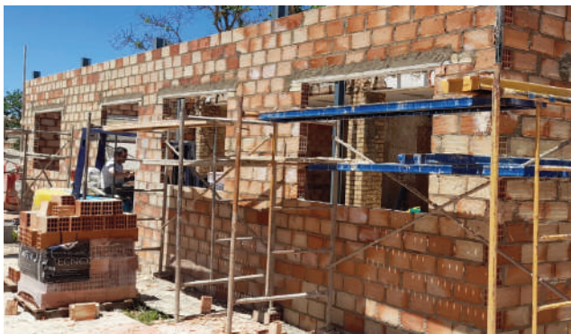
Imagen de la obra. VIVA
