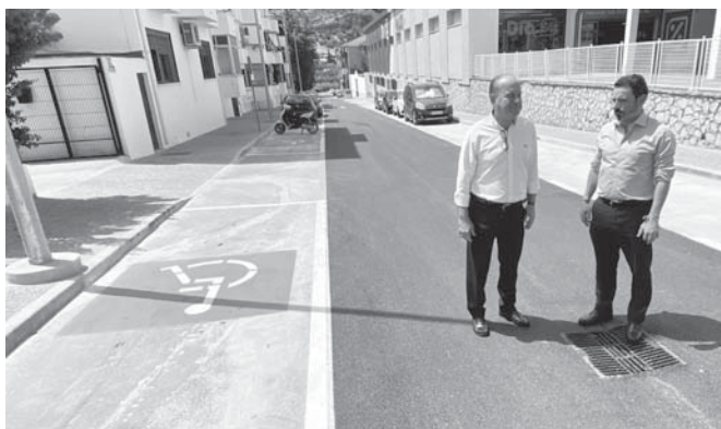
Resultado final de las obras. VIVA
