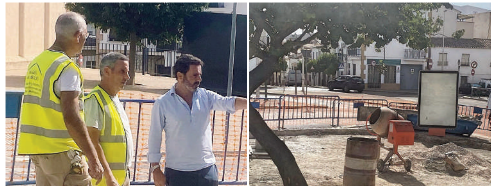
Carmona visitando el inicio de los trabajos. VIVA
