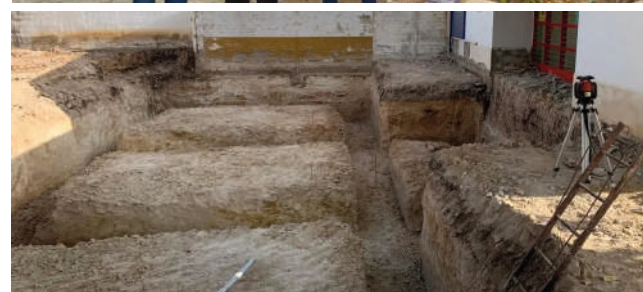
Obras en la guardería. VIVA
