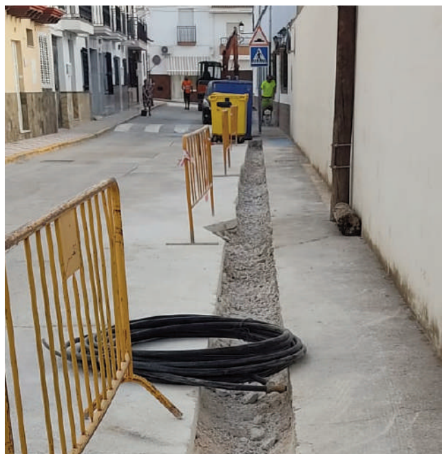
Sustitución de la red de agua. VIVA
