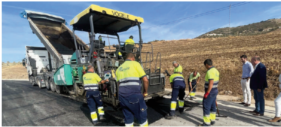
Trabajos de asfalto en parte de la carretera. VIVA
