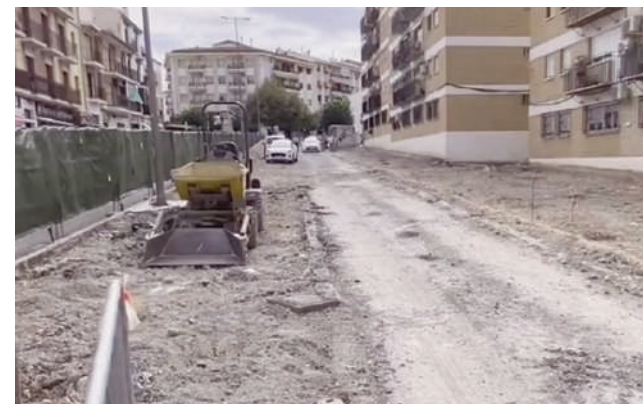
Obras en la vía de servicio de la avenida. VIVA
