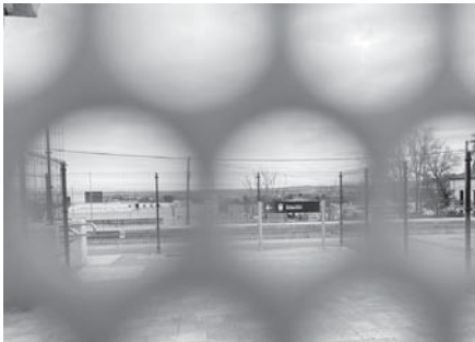
Vista de la pasarela peatonal. VIVA
