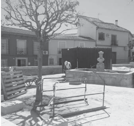
Albañiles en Antequera. VIVA
