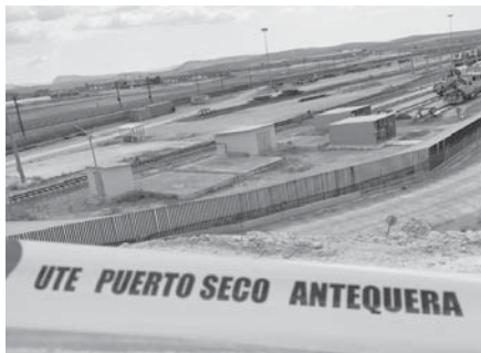
Obras del Puerto Seco de Antequera. VIVA
