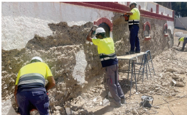
Comienzo de las obras. VIVA
