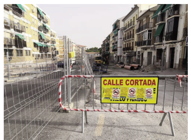
Avenida de La Legión en obras. VIVA
