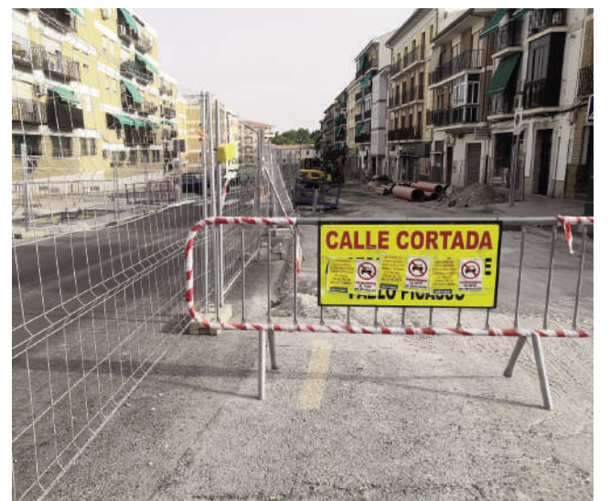
Avenida de La Legión en obras. VIVA
