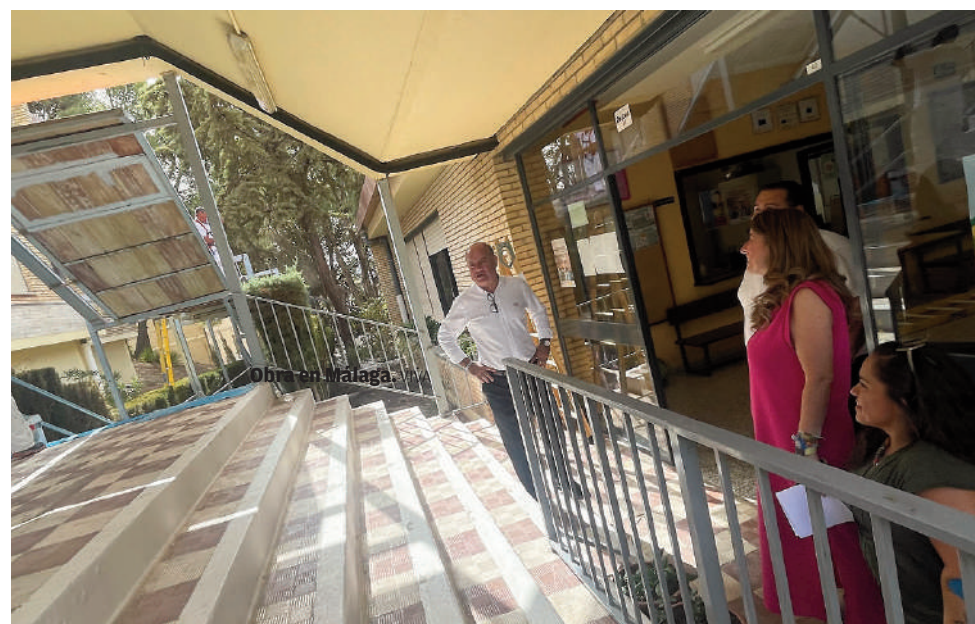
Obras de mantenimiento. VIVA
