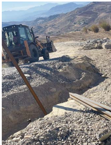
Trabajos de drenaje. VIVA
