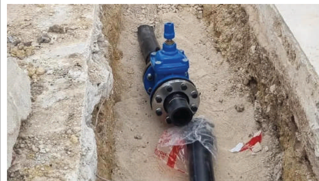
Obras en Fuente de Piedra VIVA
