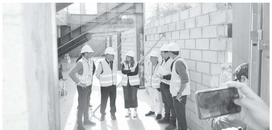
Visita a los trabajos. VIVA
