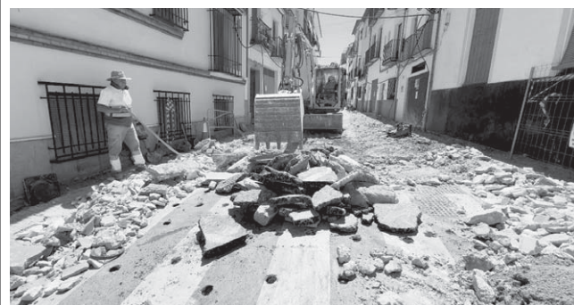
Obras Antequera. VIVA
