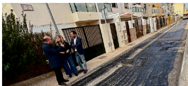
Reasfaltado en La Quinta. VIVA
