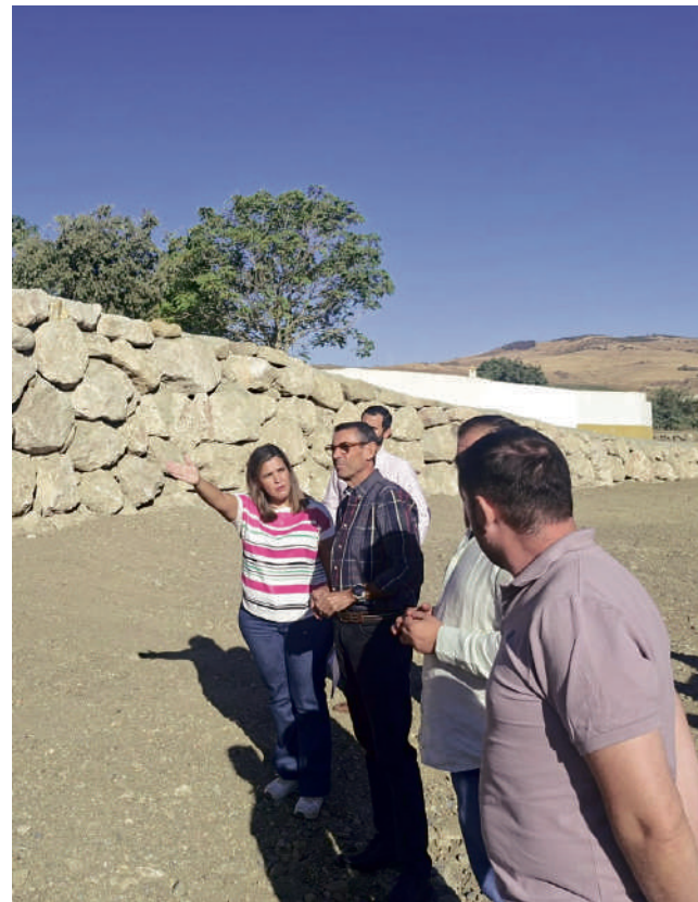
Visita a los trabajos realizados. VIVA
