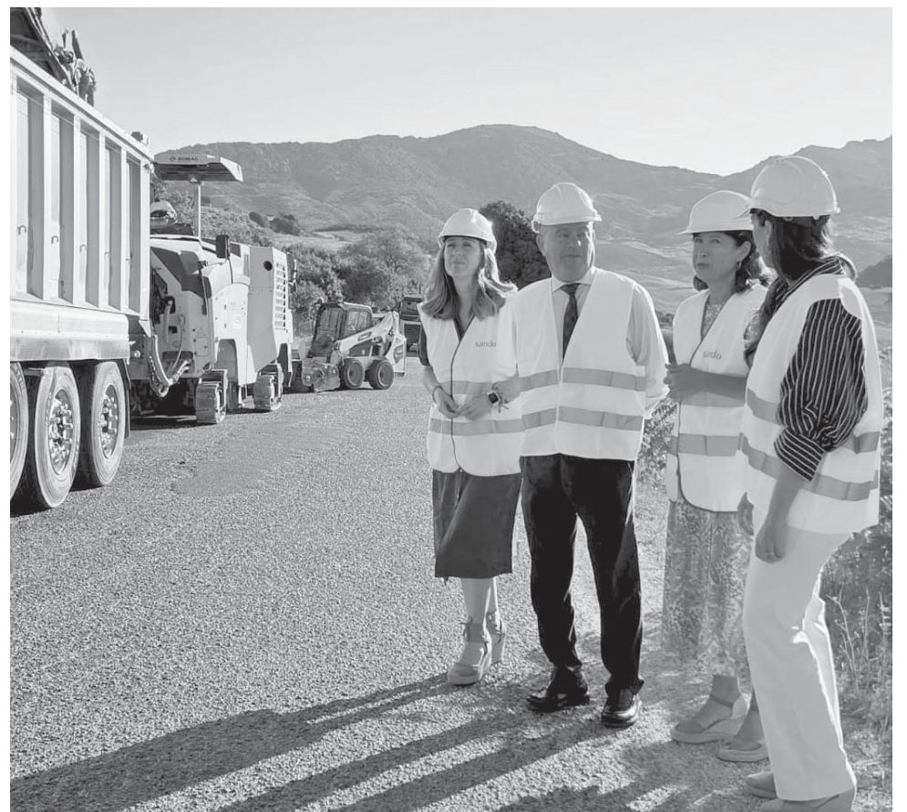
Visita a las obras de la carretera. VIVA
